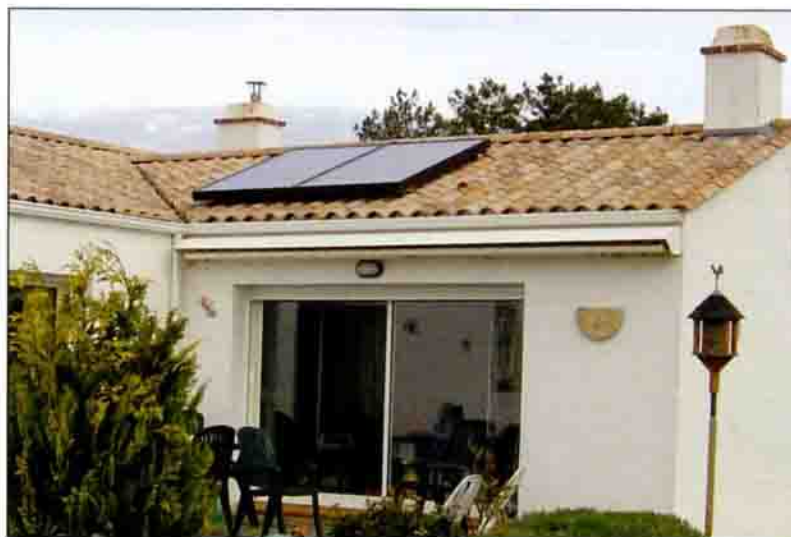
Les capteurs solaires thermiques font faire des économies et évitent l'émission de CO 2 .
